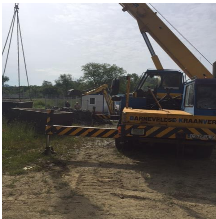
Lucrări la rețeaua de alimentare cu apă și canalizare
