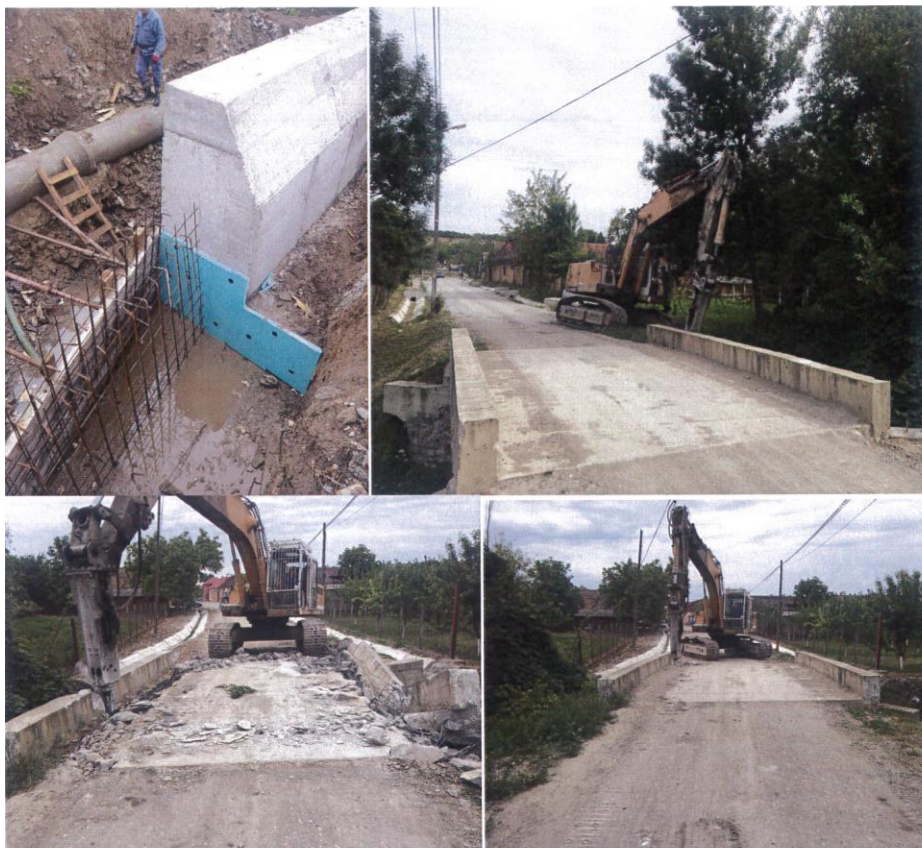
Lucrări la podul din Comună
