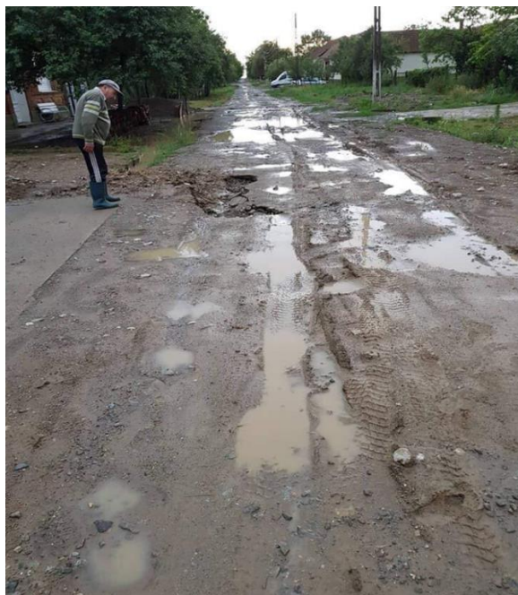
Stradă comunală înainte de reabilitare
