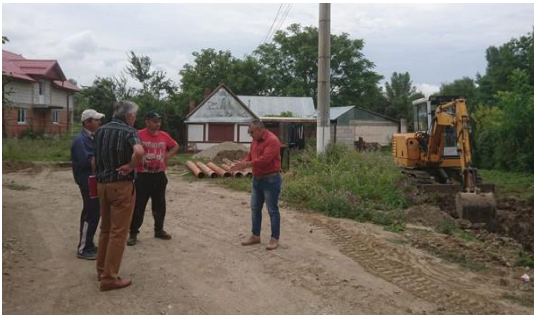
Lucrări la extinderea rețelei de alimentare cu apă și canalizare cu branșare
